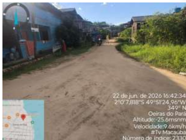
FOTO 01: INÍCIO DO TRECHO.
