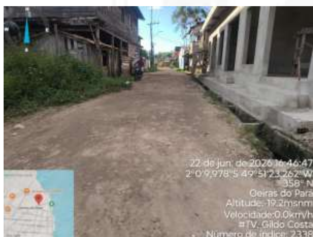
FOTO 01 INÍCIO DO TRECHO.
