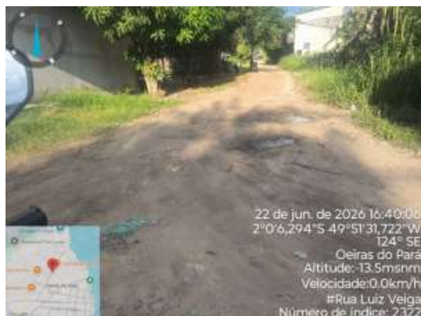
FOTO 01: INÍCIO DO TRECHO.
