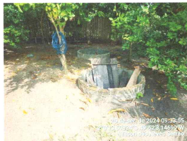
Foto 06: MSD 12 WILSON DAS NEVES SERRÃO. Vistas externas do MSD 12.
