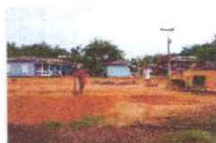
Fotografia Antes Do Início Da...
