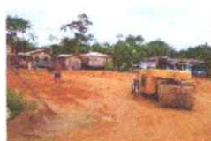
Fotografia Antes Do Início Da...
