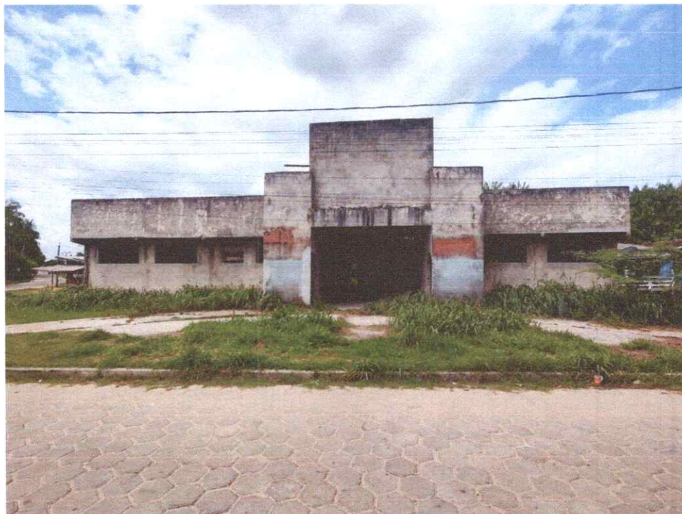
Fachada da obra
