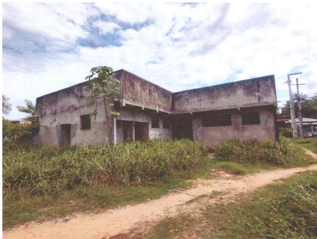
Fundos da obra
