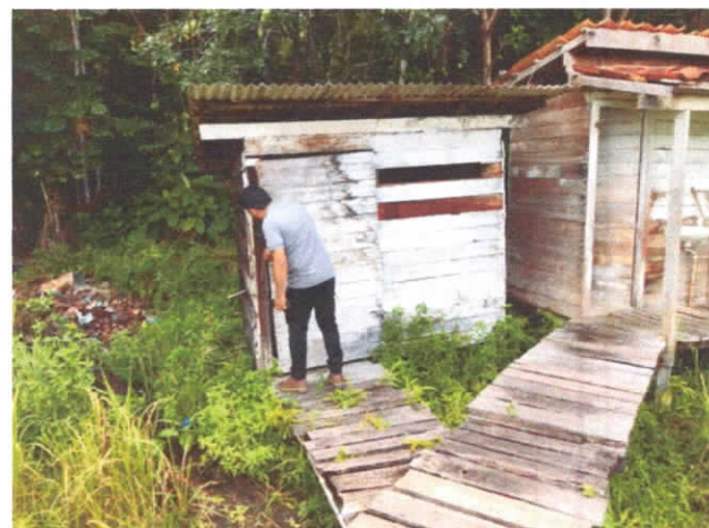
FOTO 16: VISTA DA COBERTURA DA ÁREA DOS BANHEIROS.
