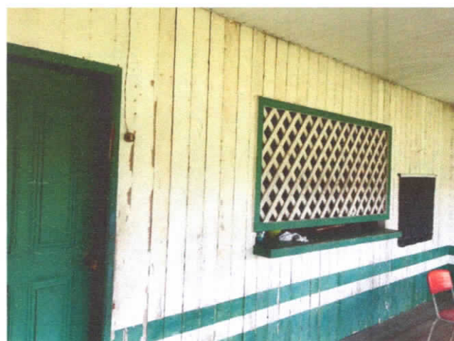
FOTO 08: VISTA DO ACESSO À COZINHA.
