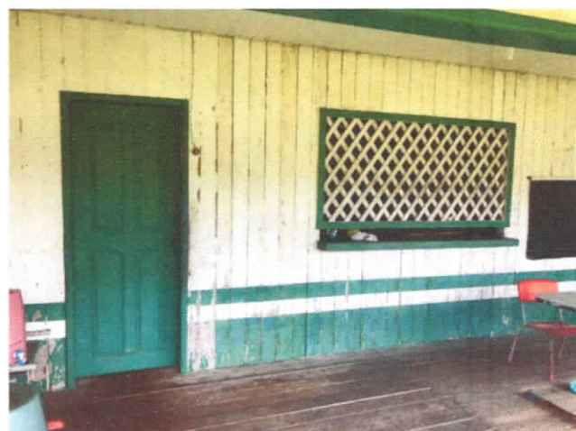
FOTO 10: VISTA DE PARTE DA COZINHA E ACESSO AO DEPÓSITO E SECRETARIA.
