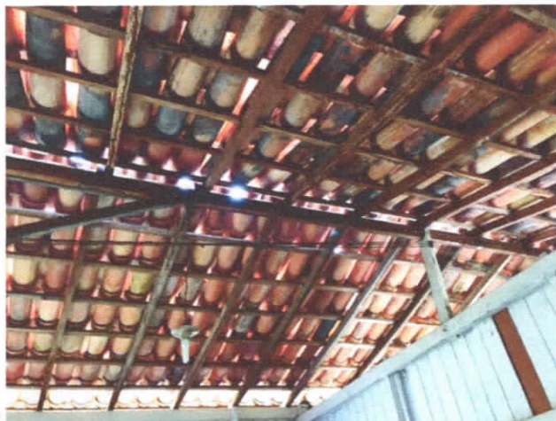
FOTO 11: VISTA INTERNA DE UMA DAS SALAS DE AULA.
