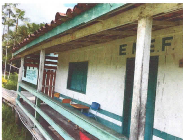
FOTO 07: VISTA DA CIRCULAÇÃO FRONTAL DA ESCOLA.
