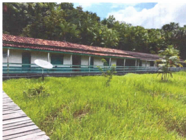
FOTO 02: VISTA DE PARTE DA PONTE DE ACESSO À ESCOLA PELO RIO MOCAJATUBA.
