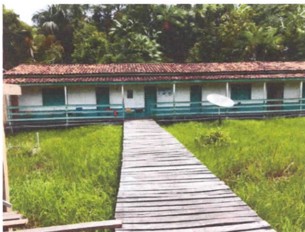
FOTO 01: VISTA DA FACHADA PRINCIPAL DA ESCOLA D. PEDRO I.
