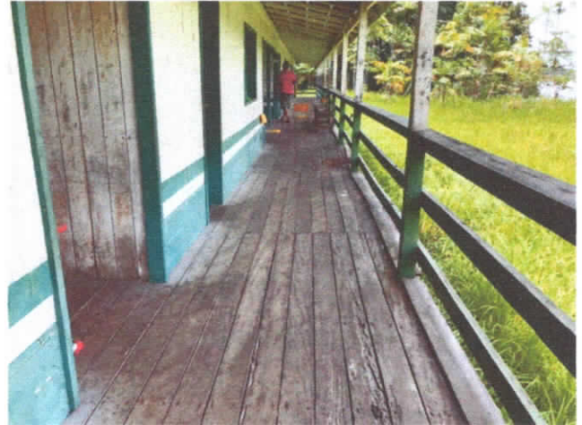
FOTO 06: VISTA INTERNA DA CIRCULAÇÃO FRONTAL DA ESCOLA.
