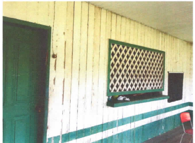
FOTO 08: VISTA DO ACESSO À COZINHA.
