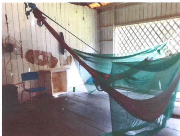
FOTO 13: VISTA DE PAREDE EM DETERIORAÇÃO C/ MARCA DE INFILTRAÇÃO.
