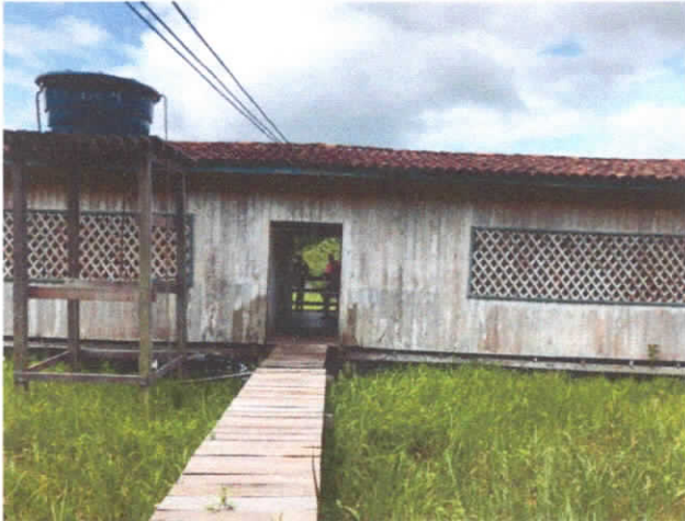
FOTO 05: VISTA DE PARTE DOS FUNDOS E RESERVATÓRIO DE ABASTECIMENTO DE ÁGUA.
