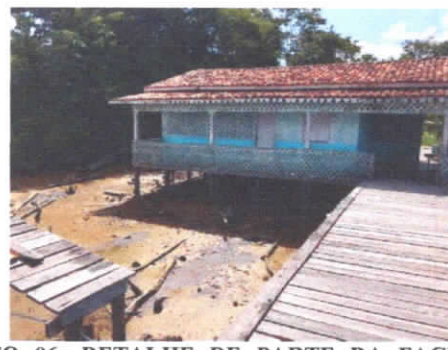
FOTO 06: DETALHE DE PARTE DA FACHADA PRINCIPAL DA ESCOLA – ILHA ATURIÁ.
