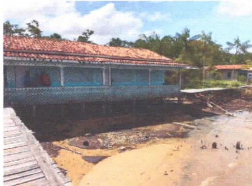
FOTO 07: DETALHE DE PARTE DA FACHADA PRINCIPAL DA ESCOLA – ILHA ATURIÁ.
