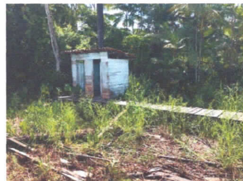
FOTO 14: DETALHE DOS SANITARIOS INADEQUADOS PARA O USO.
