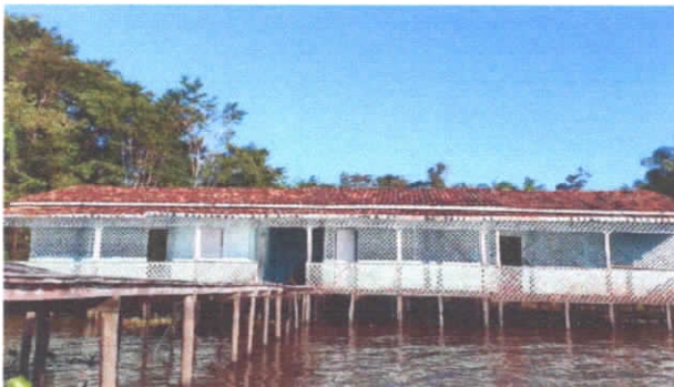
FOTO 03: DETALHE DA FACHADA PRINCIPAL DA ESCOLA – ILHA ATURIÁ.
