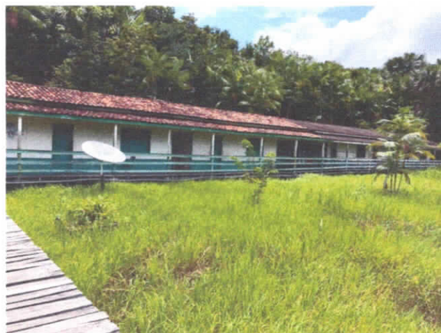
FOTO 02: VISTA DE PARTE DA PONTE DE ACESSO À ESCOLA PELO RIO MOCAJATUBA.
