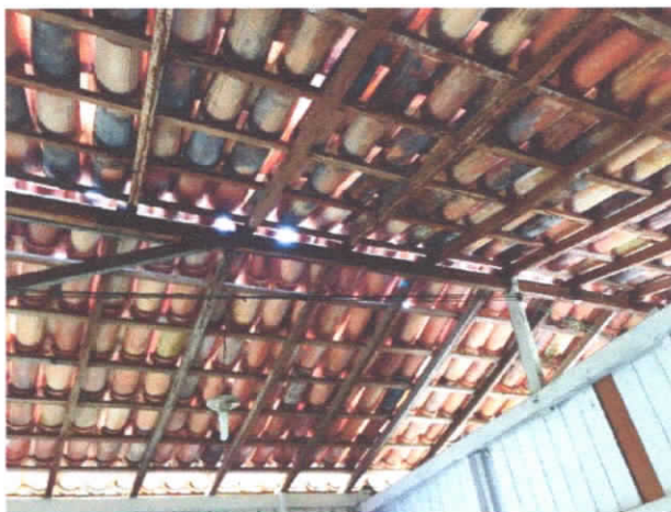
FOTO 11: VISTA INTERNA DE UMA DAS SALAS DE AULA.
