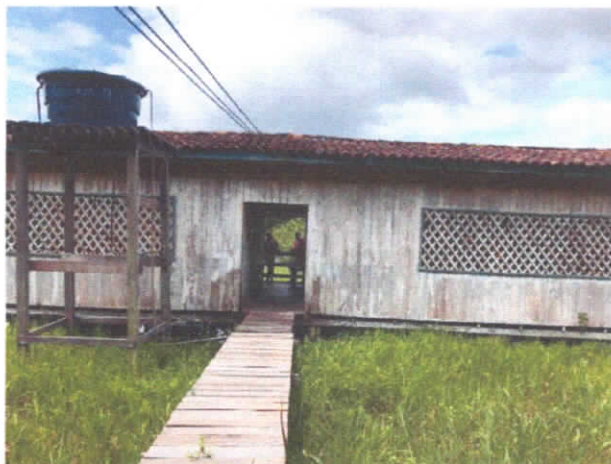
FOTO 05: VISTA DE PARTE DOS FUNDOS E RESERVATÓRIO DE ABASTECIMENTO DE ÁGUA.
