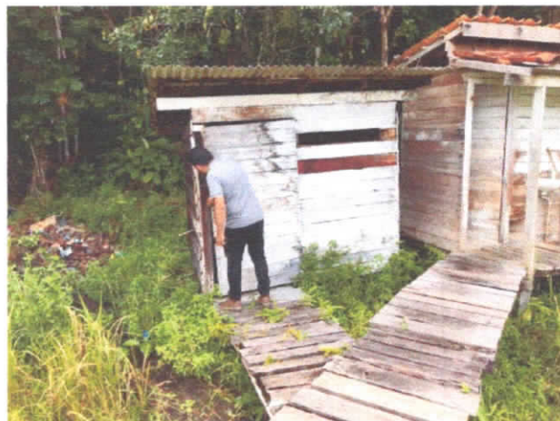
FOTO 16: VISTA DA COBERTURA DA ÁREA DOS BANHEIROS.
