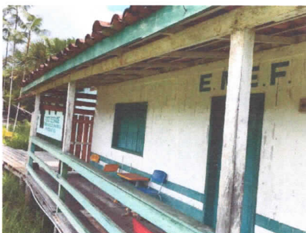
FOTO 07: VISTA DA CIRCULAÇÃO FRONTAL DA ESCOLA.
