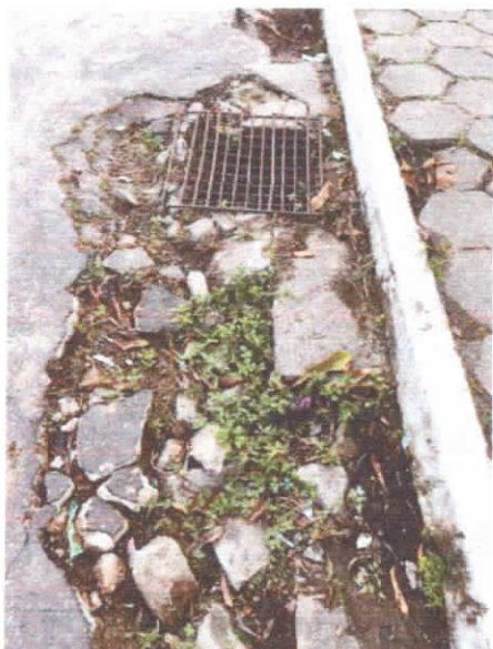
REGISTRO 11: VISTA DA DRENAGEM PLUVIAL PROFUNDA A IMPLANTAR.
