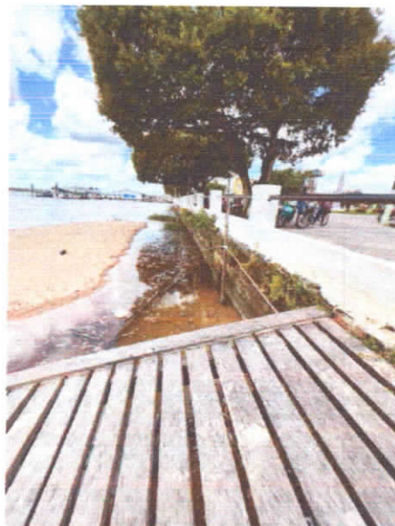
REGISTRO 14: VISTA DA ORLA A REVITALIZAR – CONSTRUÇÃO DO MURO DE ARRIMO (ÁREA DA PRAIA).
