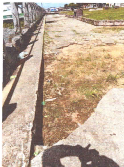
REGISTRO 02: VISTA DE PISO A REASSENTAR EM BLOKRETES.
