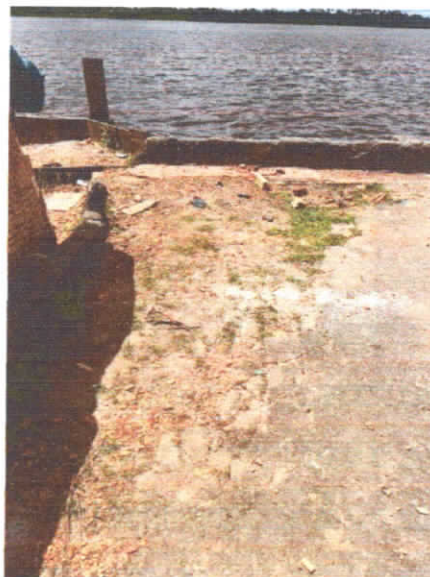
REGISTRO 10: DETALHE DA PRAÇA À MARGEM DO RIO – MURO DE ARRIMO A CONSTRUIR.
