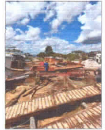
IMG.08: Vista geral da casa e do muro de alvenaria Autor: [Nome do Autor] Data: [Data]
