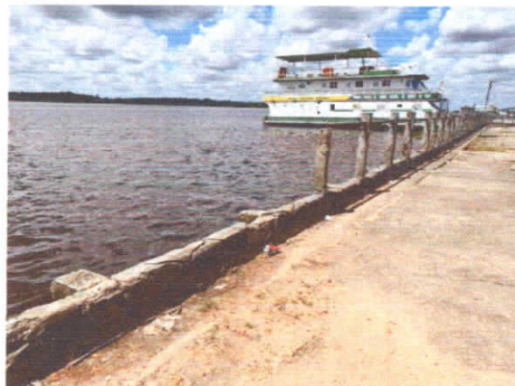
REGISTRO 04: DETALHE DA CALÇADA DA PRAÇA A REVITALIZAR E MURO DE ARRIMO A CONSTRUIR A 2,50 m ALÉM DA MARGEM.
