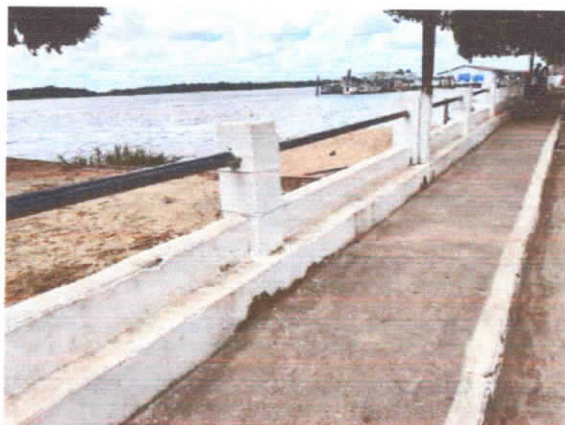
REGISTRO 13: VISTA DA ORLA A REVITALIZAR – CONSTRUÇÃO DO MURO DE ARRIMO (ÁREA DA PRAIA).
