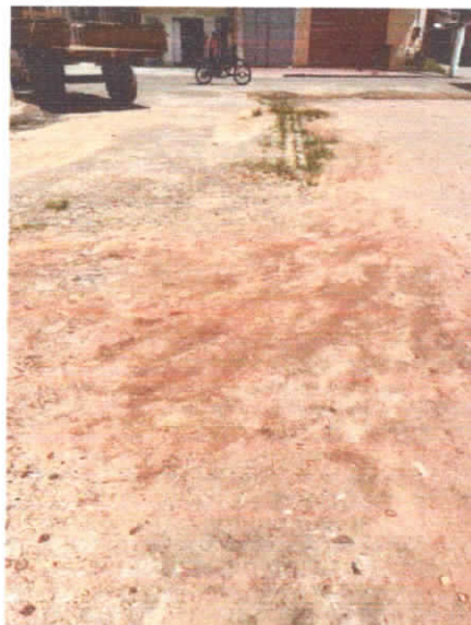
REGISTRO 12: VISTA DE PARTE DO CALÇAMENTO A REVITALIZAR.
