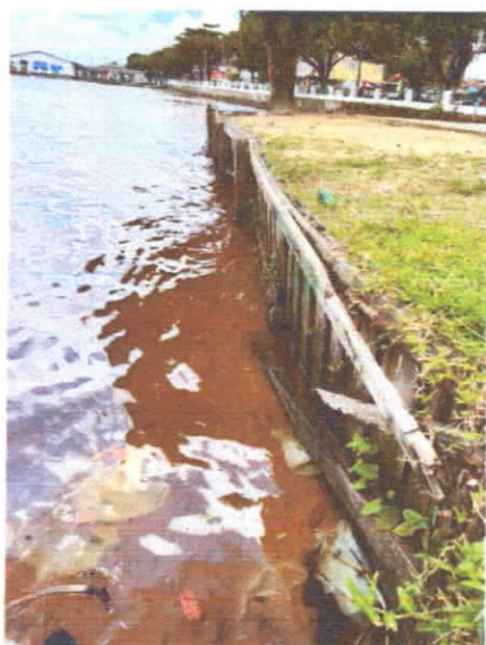
REGISTRO 15: VISTA DA ORLA A REVITALIZAR – CONSTRUÇÃO DO MURO DE ARRIMO (ÁREA DA PRAIA).
