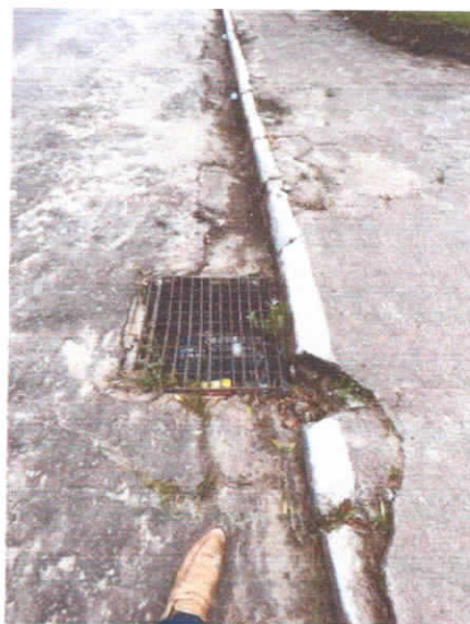
REGISTRO 08: VISTA DA DRENAGEM PLUVIAL A REVITALIZAR.
