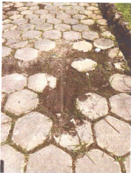
REGISTRO 05: VISTA DO PISO INTERNO DA PRAÇA A REVITALIZAR.
