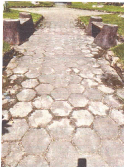
REGISTRO 06: VISTA DO PISO INTERNO DA PRAÇA A REVITALIZAR.
