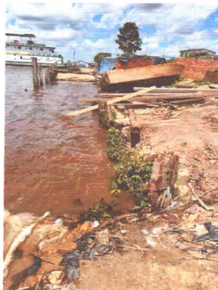
REGISTRO 16: VISTA DA ORLA A REVITALIZAR – CONSTRUÇÃO DO MURO DE ARRIMO (ÁREA DA PRAÇA).
