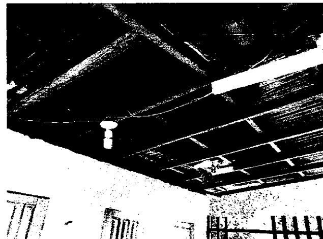
FOTO 16: VISTA DA COBERTURA DA ÁREA DOS BANHEIROS.
