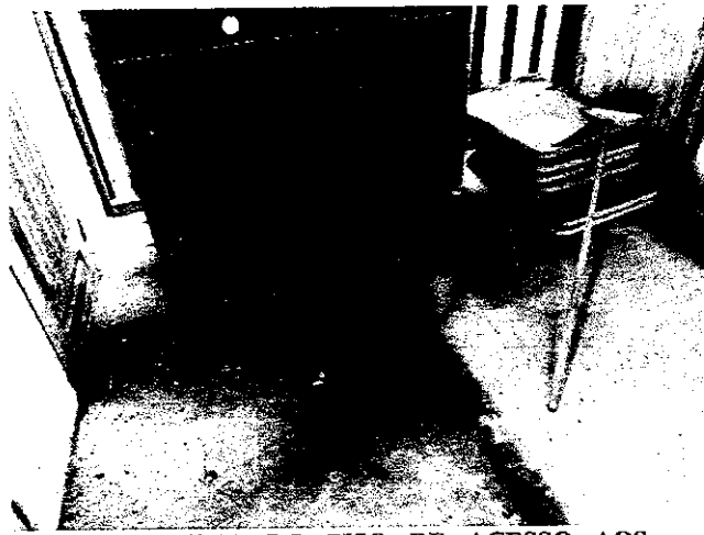
FOTO 18: VISTA DO PISO DE ACESSO AOS BANHEIROS TODO DETERIORADO.
