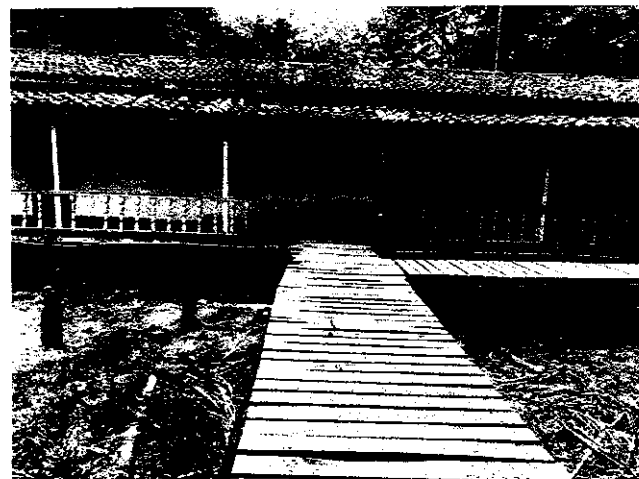
FOTO 02: VISTA DE PARTE DA PONTE DE ACESSO À ESCOLA PELO RIO PRUANÃ.
