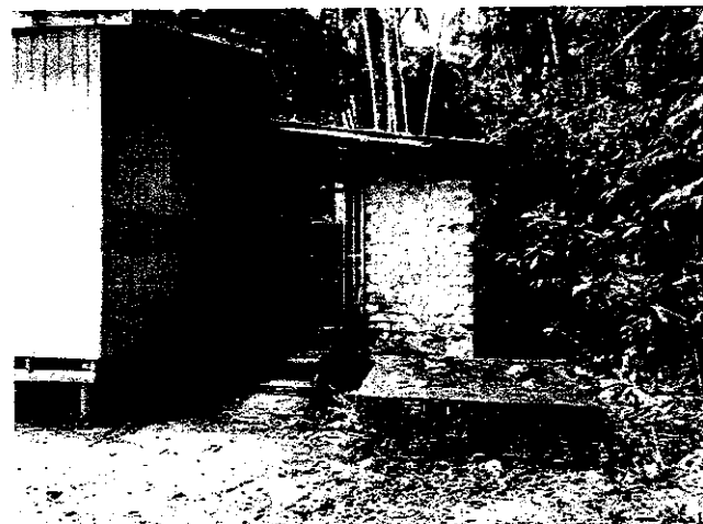
FOTO 24: DETALHE DA ÁREA DOS BANHEIROS E FOSSA SÉPTICA.
