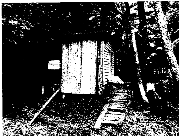
FOTO 23: VISTA DA CASA DE GERADOR EM DETERIORAÇÃO.
