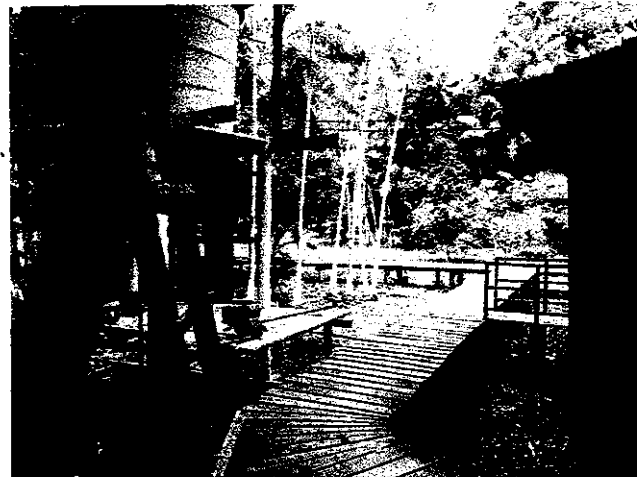
FOTO 20: DETALHE EXTERNO DAS PONTES DE ACESSO.
