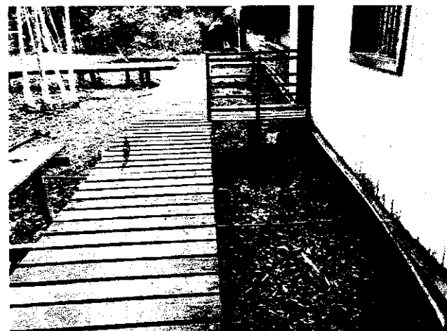
FOTO 22: DETALHE DE PARTE DA CIRCULAÇÃO EXTERNA DA ESCOLA.
