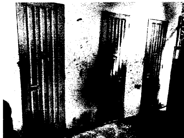
FOTO 15: VISTA DOS BANHEIROS EM DETERIORAÇÃO.
