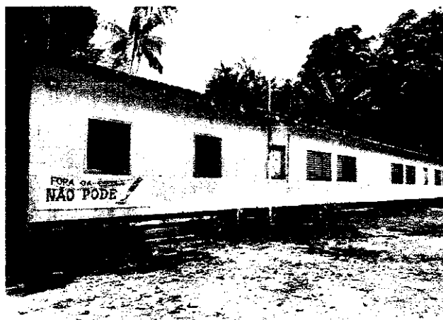
FOTO 03: DETALHE DA FACHADA POSTERIOR TODA DETERIORADA.
