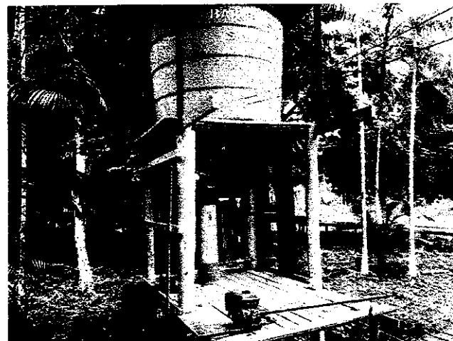
FOTO 26: VISTA DO ELEVADO D'ÁGUA COM TRATAMENTO APROPRIADO.
