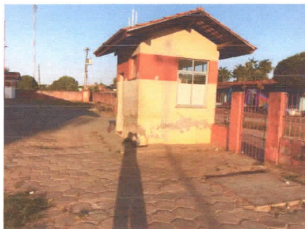
FOTO 06: VISTA EXTERNA DA GUARITA DE ENTRADA.
