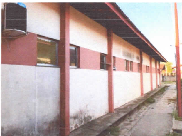
FOTO 13: DETALHE EXTERNO DO BLOCO CIRÚRGICO/OBSTÉTRICO.
