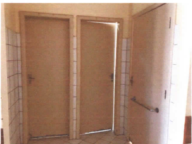
FOTO 39: VISTA DAS PORTAS DE ACESSO AOS SANITÁRIOS.
