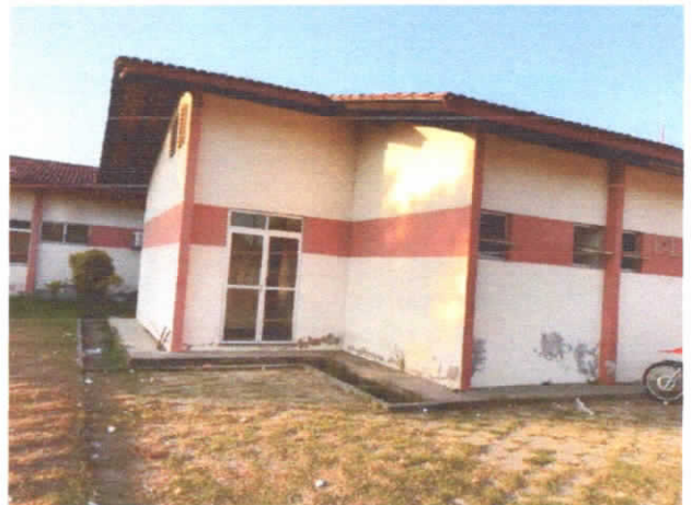
FOTO 04: VISTA EXTERNA DE PARTE DA FACHADA DO BLOCO ADMINISTRATIVO E APOIO AO DIAGNÓSTICO.
