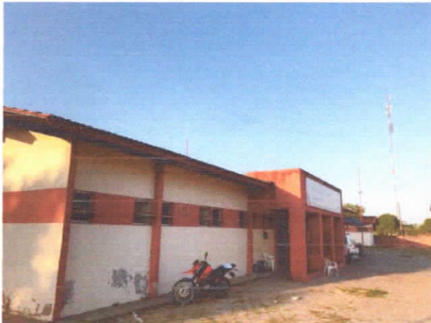
FOTO 01: VISTA DA TESTADA PRINCIPAL DO HOSPITAL.
