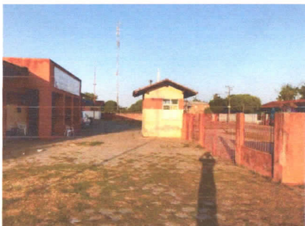
FOTO 10: VISTA DE PARTE DA FACHADA DO MURO, GUARITA E PÁTIO DE ENTRADA AO HOSPITAL.
