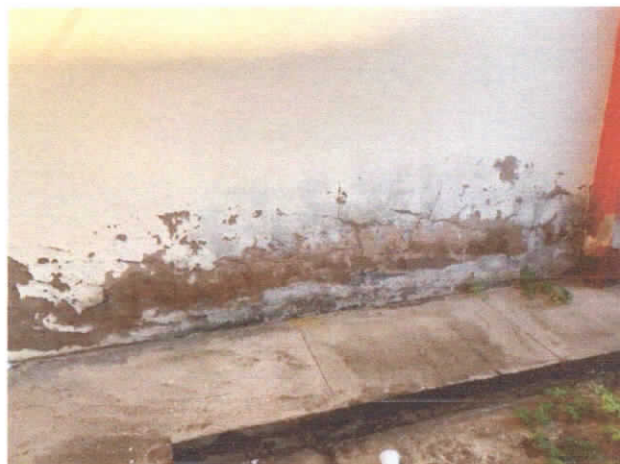
FOTO 18: VISTA DA CALÇADA DE PROTEÇÃO E PAREDE EXTERNA - BLOCO CIRÚRGICO.
