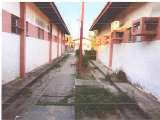
FOTO 11: VISTA EXTERNA ENTRE OS BLOCOS CIRÚRGICO/OBSTÉTRICO E APOIO AO DIAGNÓSTICO.
