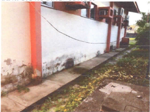
FOTO 16: DETALHE EXTERNO DO BLOCO ADMINISTRATIVO.
