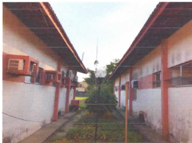
FOTO 12: VISTA EXTERNA ENTRE OS BLOCOS ADMINISTRATIVO E INTERNAÇÃO.
