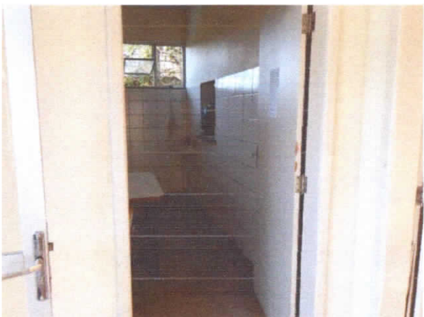
FOTO 45: VISTA ACESSO AO REFEITÓRIO - BLOCO DE SERVIÇO.
