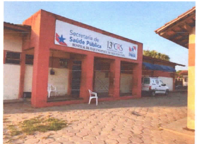
FOTO 02: VISTA DO ACESSO PRINCIPAL À RECEPÇÃO DO HOSPITAL.
