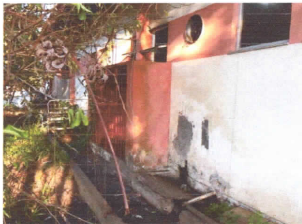
FOTO 24: VISTA DOS FUNDOS DO BLOCO DE SERVIÇOS – COZINHA.
