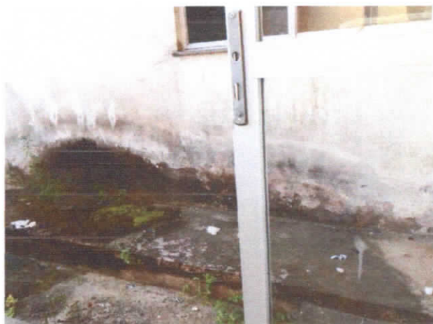
FOTO 17: DETALHE DE PARTE DA PORTA DE CIRCULAÇÃO E CALÇADA DE PROTEÇÃO DO BLOCO DE INTERNAÇÃO.
