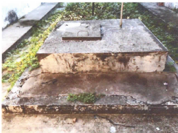
FOTO 20: VISTA DO TANQUE SÉPTICO ENTRE OS BLOCOS ADMINISTRATIVO E DE INTERNAÇÃO.
