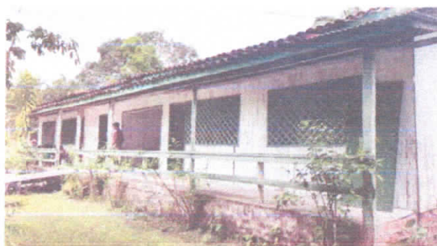
FOTO 02: VISTA DA FACHADA PRINCIPAL DA ESCOLA GUIMARÃES ROSA.
