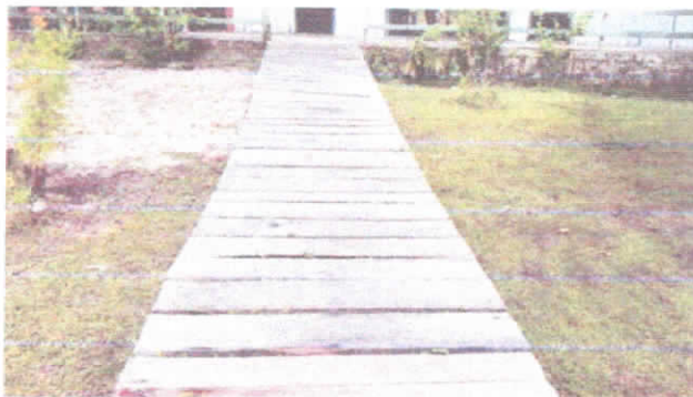
FOTO 19: VISTA DA CIRCULAÇÃO EXTERNA DE ACESSO À ESCOLA. EM MADEIRA.
