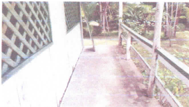
FOTO 10: VISTA DE PARTE DO PISO DA CIRCULAÇÃO.
