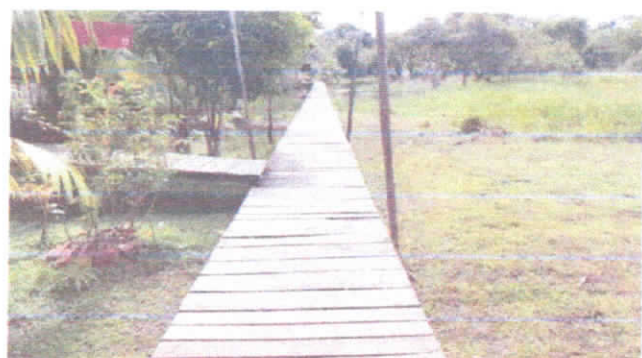
FOTO 20: VISTA DA PASSARELA EM MADEIRA DE ACESSO À ESCOLA C=96,50m.
