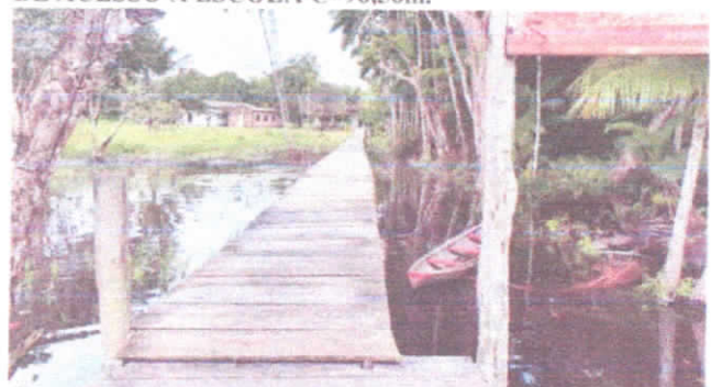
FOTO 22: VISTA LONGITUDINAL DA PASSARELA DE ACESSO À ESCOLA C=96,50m.
