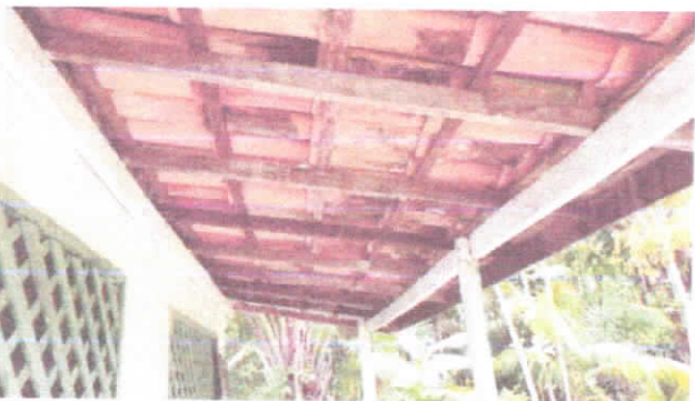
FOTO 11: VISTA DE PARTE DA COBERTURA EM TELHA DE BARRO.
