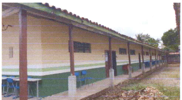
FOTO 18: VISTA DE UM DOS BLOCOS A REVITALIZAR A COBERTURA, PISO E ESQUADRIAS.
