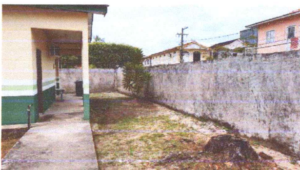
FOTO 08: VISTA DE PARTE DA CIRCULAÇÃO A CONSTRUIR PASSARELA COBERTA.
