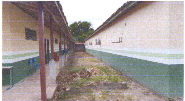
FOTO 14: VISTA EXTERNA ENTRE OS BLOCOS A ESTRUTURAR COBERTURA C/ TELHAS PLAN.
