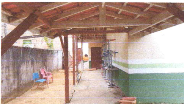
FOTO 24: VISTA DA CIRCULAÇÃO A REVITALIZAR COM ESTRUTURA E TELHAS PLAN.
