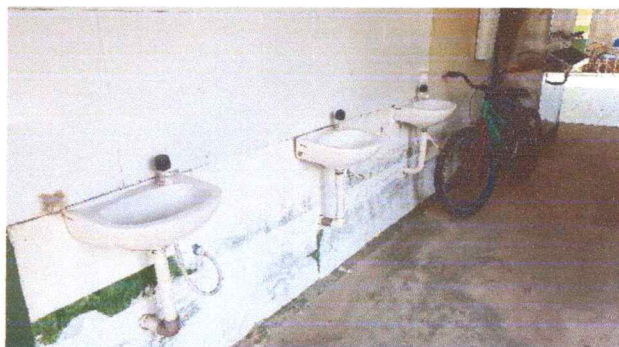
FOTO 22: VISTA DOS LAVATÓRIOS A REVITALIZAR C/ BANCADA E INSTALAÇÕES.
