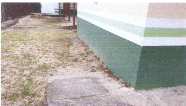
FOTO 19: VISTA DA CIRCULAÇÃO A CONSTRUIR PASSARELA COBERTA.
