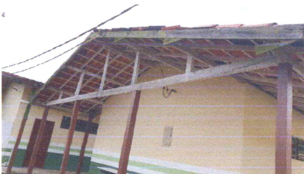
FOTO 17: VISTA EXTERNA DA COBERTURA A REVITALIZAR C/ ESTRUTURA E TELHAS PLAN.
