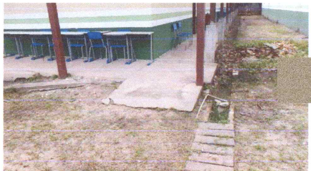
FOTO 16: VISTA DA CIRCULAÇÃO A CONSTRUIR PASSARELA COBERTA.
