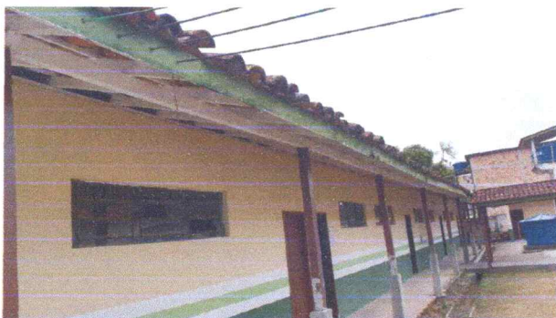
FOTO 21: VISTA EXTERNA DE UM DOS BLOCOS A REVITALIZAR COBERTURA, PISO E ESQUADRIAS.
