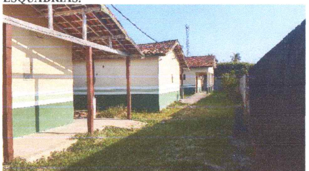
FOTO 20: VISTA DOS BLOCOS A REVITALIZAR E CONSTRUIR PASSARELA DE ACESSO A ELAS.
