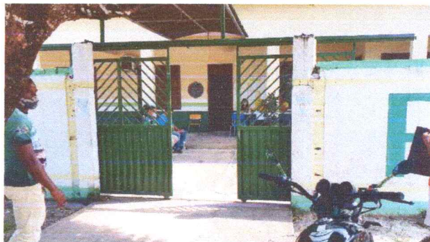
FOTO 02: VISTA DO PORTÃO DE ACESSO PRINCIPAL À ESCOLA.
