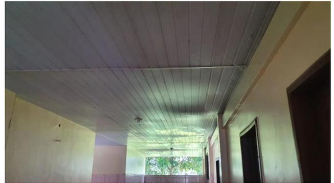
**FOTO 24:** VISTA DE PARTE DO FORRO PVC A REVITALIZAR.
