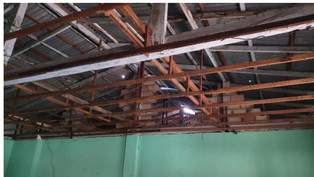
**FOTO 02:** VISTA INTERNA DO BLOCO CENTRAL, FORRO E COBERTURA DETERIORADO.
