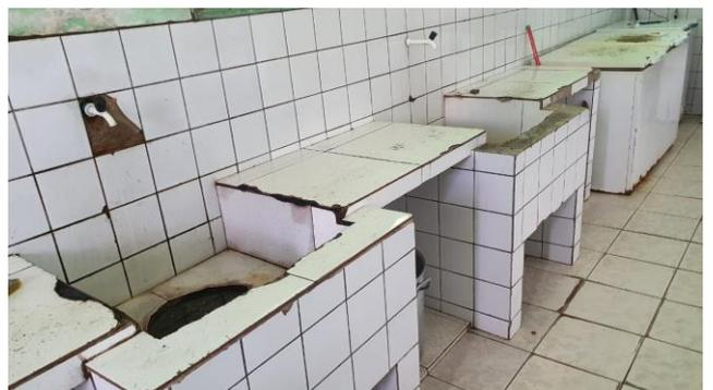
**FOTO 20:** VISTA DOS TANQUES EM ALVENARIA DA COZINHA A REFORMAR.
