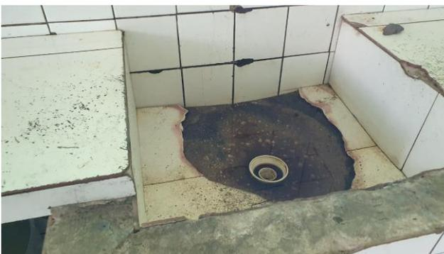
**FOTO 19:** VISTA DE PARTE DO TANQUE DE SERVIÇO A REFORMAR.
