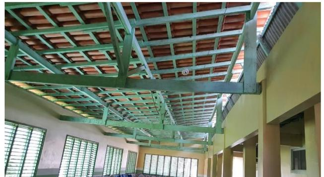
**FOTO 26:** VISTA DA COBERTURA DO REFEITÓRIO, NECESSITA DE REPAROS.
