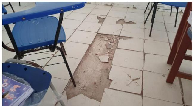
**FOTO 12:** VISTA DE PISO DETERIORADO A
