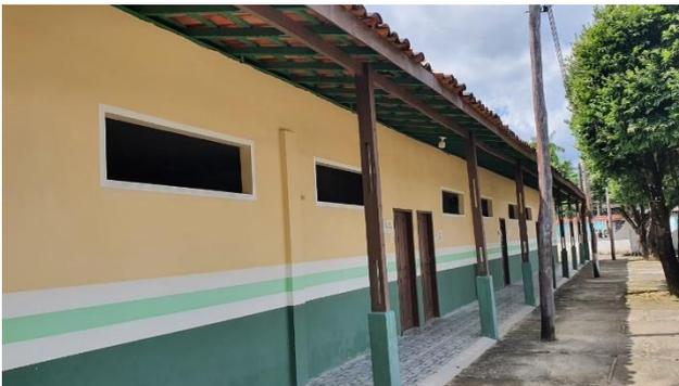
**FOTO 25:** VISTA DO BLOCO SEM ESQUADRIAS DE VIDRO, FALTA FORNECIMENTO E INSTALAÇÃO E TROCA DE PILARES DE MADEIRA P/ CONCRETO ARMADO.
