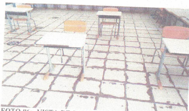
FOTO 06: VISTA DE PARTE DO PISO CERÂMICO DESGASTADO.
