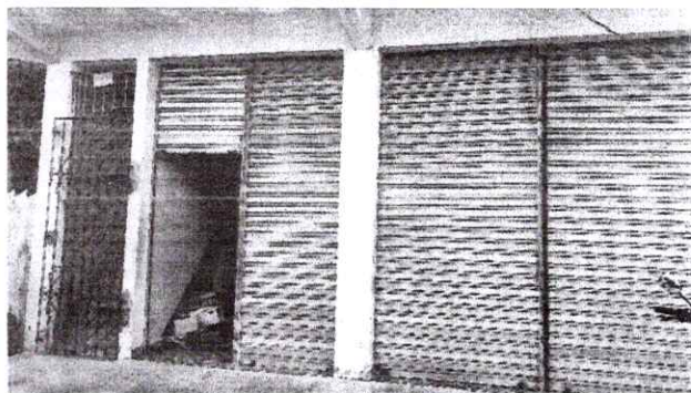
FOTO 01: VISTA DA FACHADA PRINCIPAL DA EDIFICAÇÃO.
